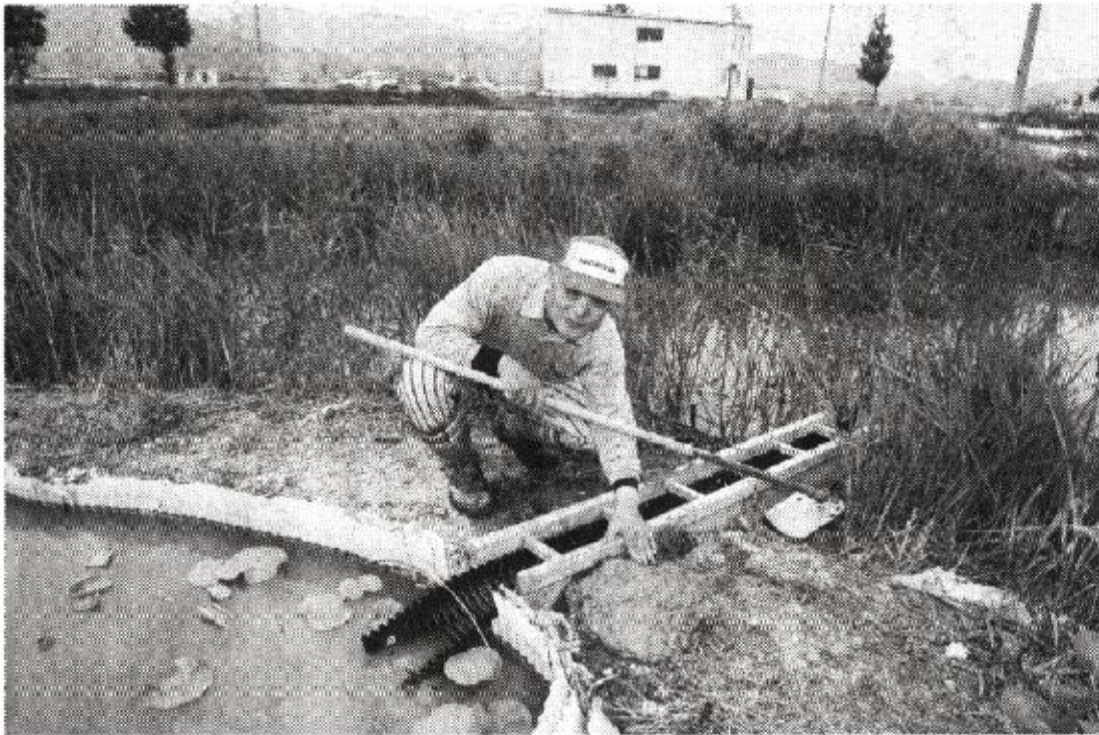
レンコン畑の一角に設置された魚道を整える斎藤政明さん ＝鳴門市大津町段関
